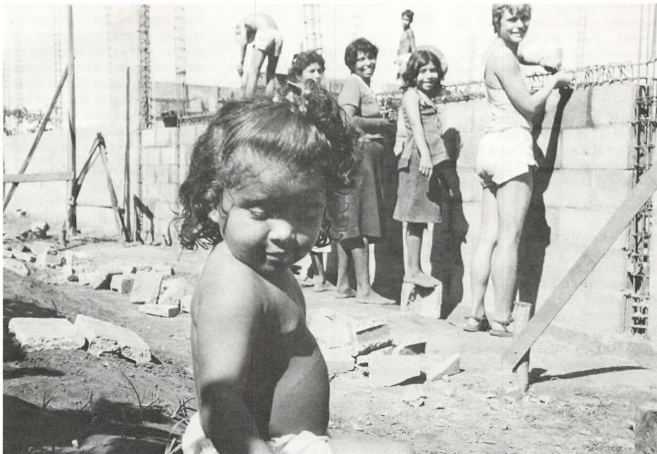
Byggebrigade i arbejde.
