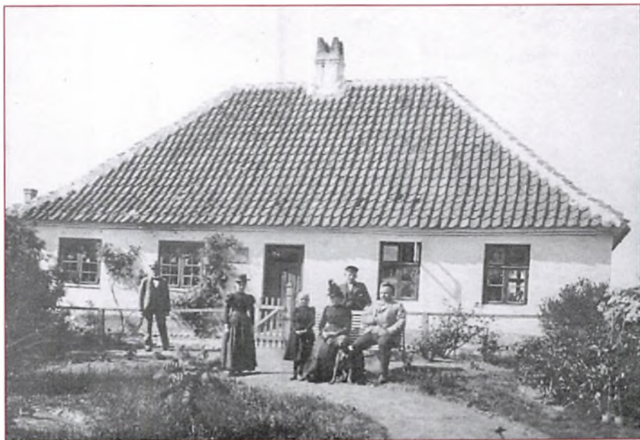
Rytterskolen i Maglebrænde fulgte skemaet for skolebyggeriet i de kongelige rytterdistrikter. Grundmuret og med tegltag skilte bygningen ved opførelsen i 1720'erne sig markant ud fra landsbyens gårde og huse. Til venstre for indgangen anes den inskriptionstavle, som frederik IV forsynede alle sine rytterskoler med. Museum Lolland-Falster.
