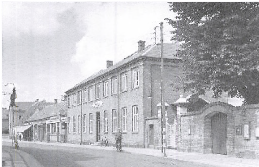
Freys Hotel var en markant bygning på Vestergade, ca. 1955. Til venstre i billedet ses gavlen af L.M.A.F.s kornmagasin.
