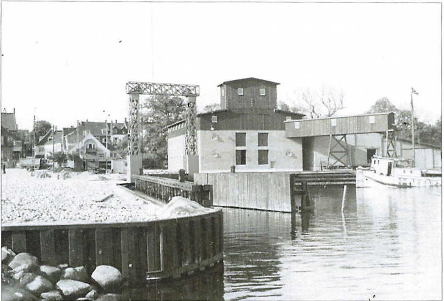
Det nye færgeleje til den nyoprettede Bogø-Stubbekøbing Overfart, 1943
