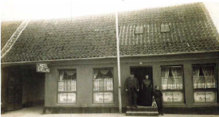
Den lave bygning efter ”P. Olsen” er ”Hotel Sjælland”, som ikke eksisterede i 1950, men som vi alligevel viser et billede af.
