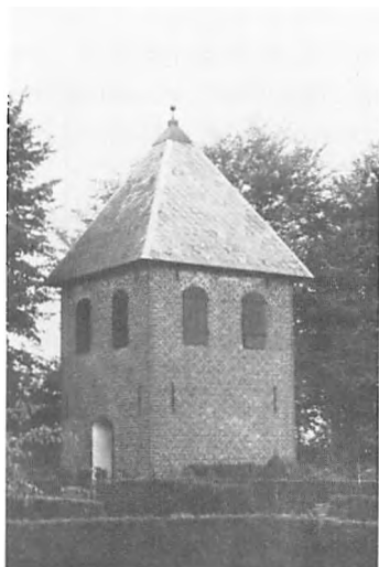
Klokkehuset i kirkegårdens sydvestre hjørne er opført 1826-28 af små, hårdtbrændte sten. Bygningen måler udvendig 4,1 m i kvadrat, 5,2 m i højden. Pyramidetaget stammer vistnok fra 1840-41. Klokkehusets forgænger var formentlig af træ – ligesom klokkehusene ved de andre kirker i Lundtoft herred. Nederste stokværk er materialerum, i øverste hænger klokkerne bag de 8 glasmuller. Heldigvis lykkedes det aldrig at få klokkehuset erstattet af et imponant tårn på kirken.
