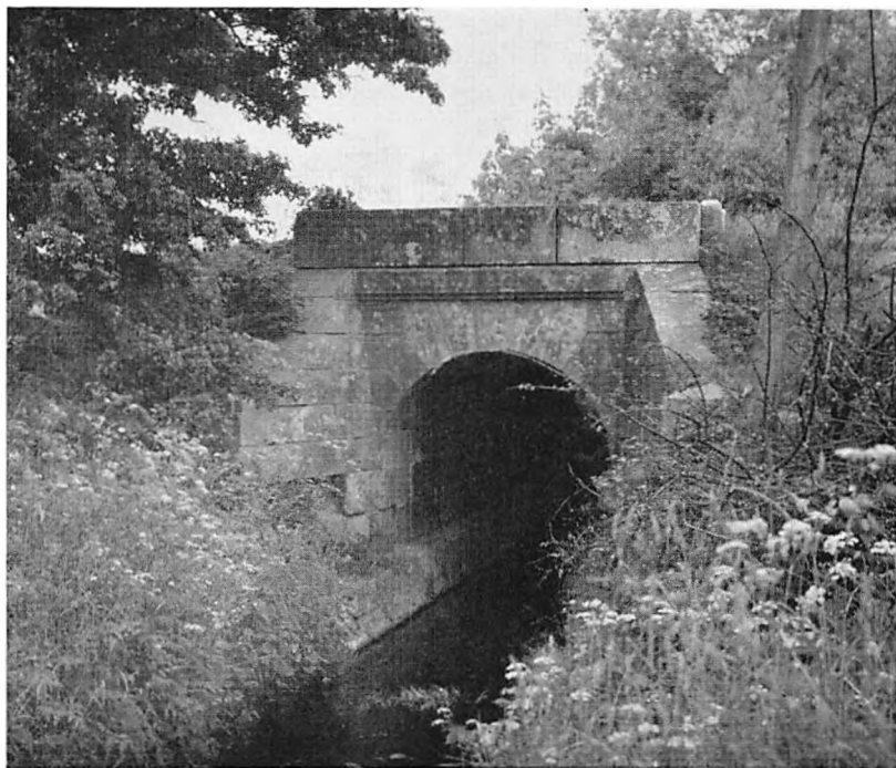
Ebbekøb bro over Langstrup å, bygget i 1775, det sidste år, der blev arbejdet på vejen. – Foto: Helge Pedersen, Hørsholm.
