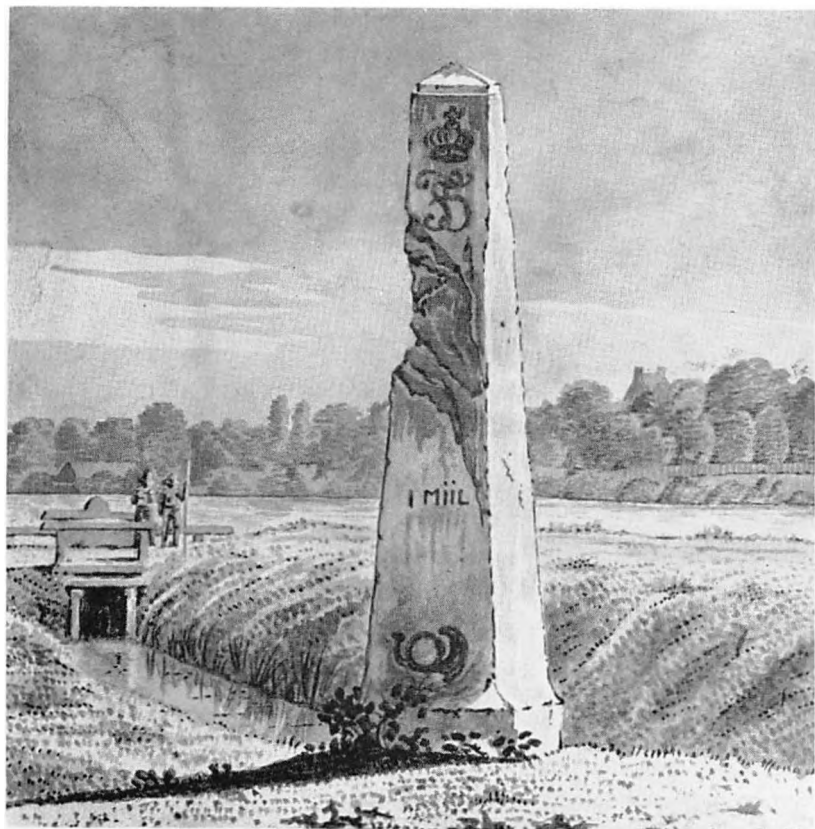
De gamle helmilepæle af norsk marmor var smukke, men materialet skrøbeligt. Martinus Rørbye har på en akvarel fra omkring 1830 vist, hvor medtaget 1-milepælen i Gentofte på det tidspunkt var. – Øregård Museum.
