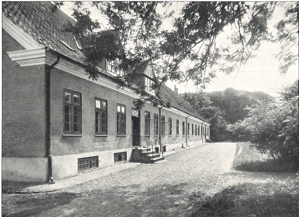
DEN AF GENERALEN OPFORTE SUKKERFABRIK I TRANEKÆR
