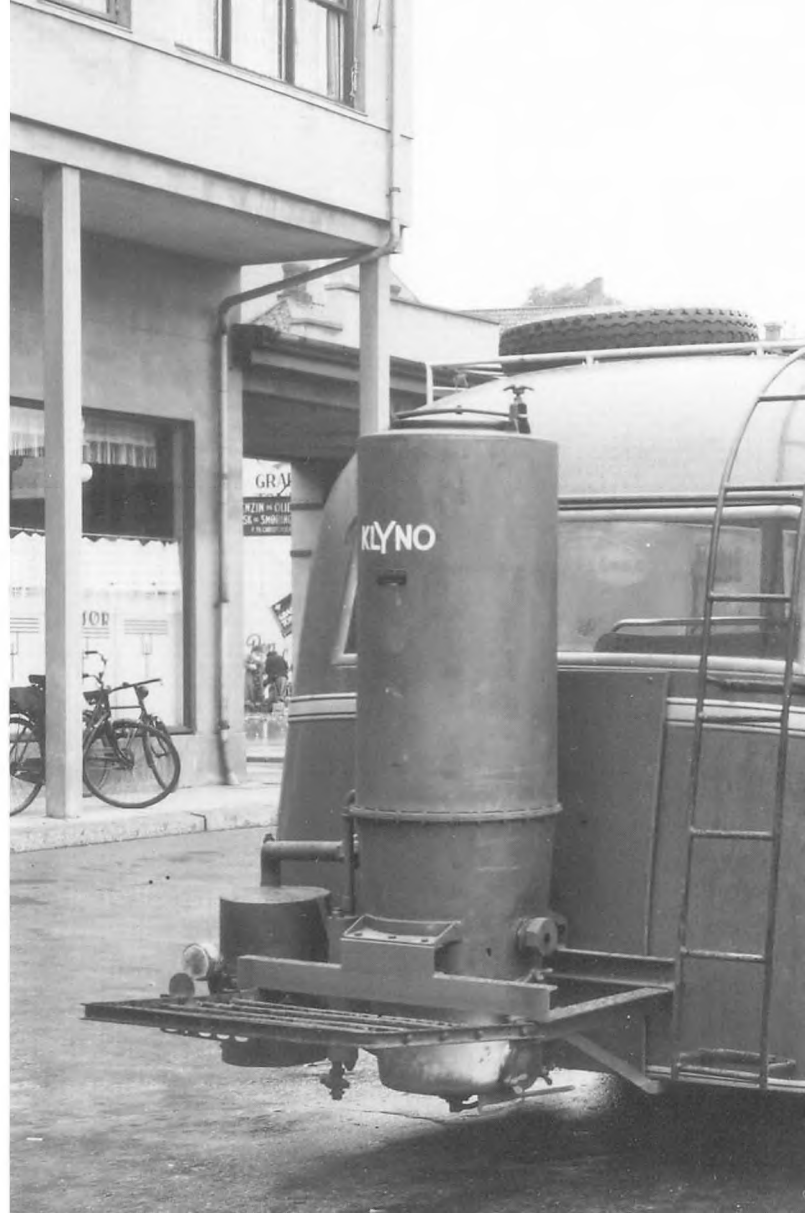
Rutebil med gasgenerator under krigen. Ca. 1942 Fotograf: Ukendt.
