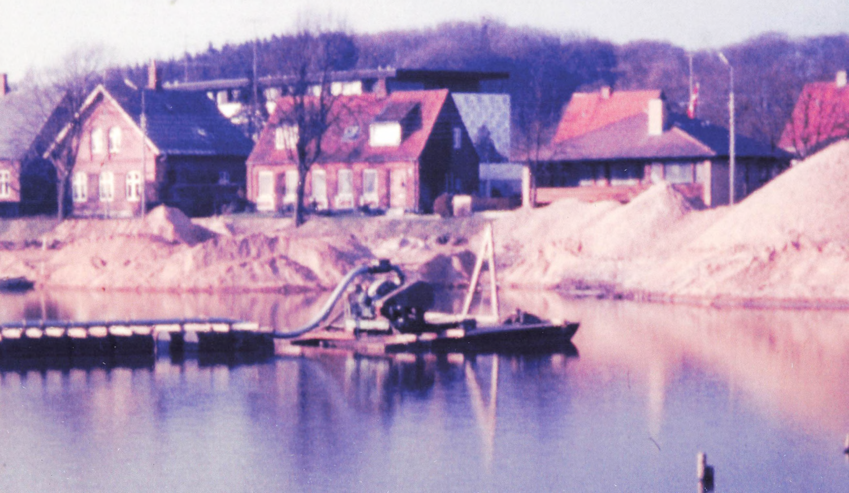
Den østlige del af Slotssøen under opfyldning i forbindelse med omlægning af Ejlersvej som følge af etableringen af Slotssøvej. 1968. Fotograf: Egon Veinholt Hansen
