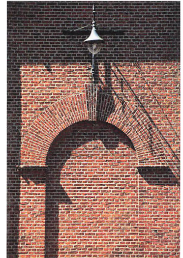
Detailfoto af østfacade med murblænding og lampe. Foto: Thomas Mølvig, 2010.
