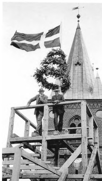
Kolding Rådhus 1923. Rejsegilde på tagrytter. Øverst står Ernst Petersen ved siden af Friis Mathiasen. Kilde: Kolding Stadsarkiv.
