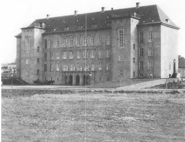
Domhuset, Domhusgade 24-26, få år efter opførelsen.
