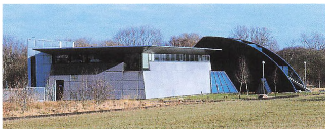
48 Kolding Kommunes Forrenseanlæg, Østerbrogade 11
