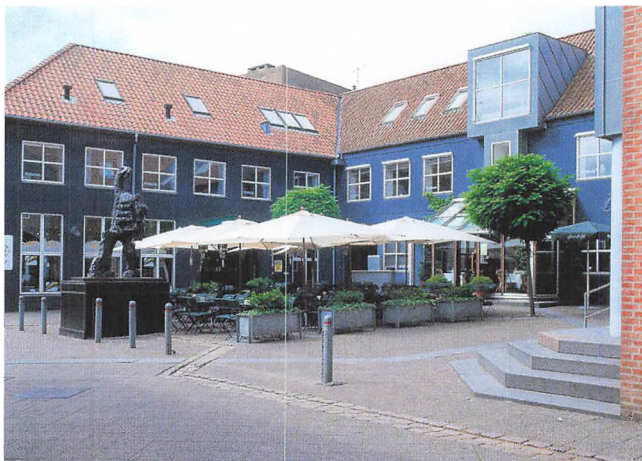
8 Slotsgade 6-8 og Lilletorv.
