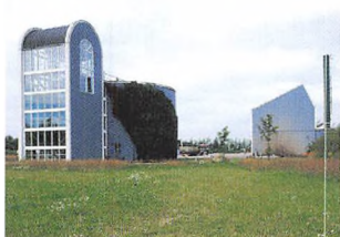
133 Kolding Centralrenseanlæg, Stenderupvej 95, Bjert.
