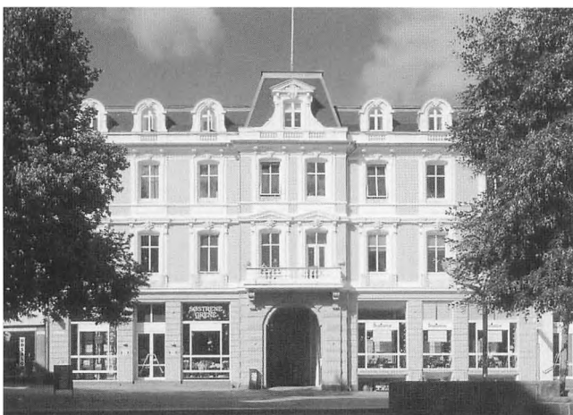
Hotel Kolding – som bygningen ser ud i dag.
