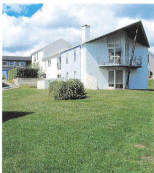
121 Fjordterrasserne, Gl. Tved 9-11.
