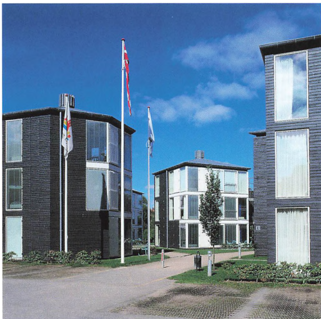
18 Kolding Byferie, Kedelsmedgangen 2.
