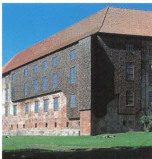
1 Koldinghus' syd-østlige hjørne, beklædt med træspån.
