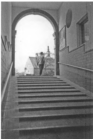
Forbindelsestunnellen mellem havnen og banegårdspladsen. Spiret og den store gavl i baggrunden er en del af bryggeriet Slotsmøllens store anlæg.
