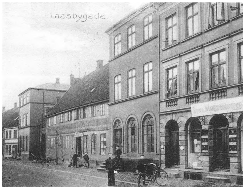
A/S P. Schou og Co.s trælasthandels ejendom Låsbygade 71-77. I sine unge år boede Christian F. Hansen i bygningen nr. 2 fra højre.
