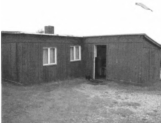
Bygning for Brunkuls museet i Søby.
