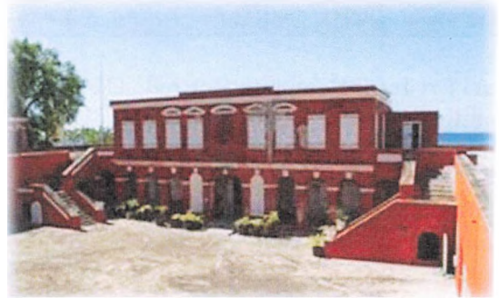
Bygning på Frederiksværn
