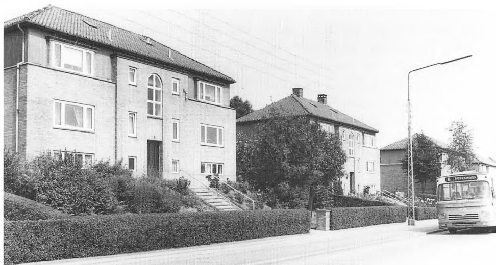
Boliger ved Ndr. Ringvej - opført 1939 som det første af AABs byggerier.
