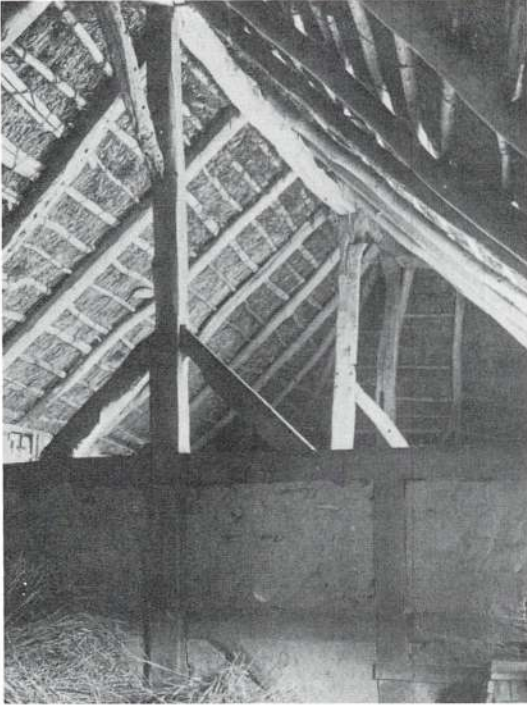
Sulekonstruktion i ladelængen i Lundagergården. Lundagergården fra Vestfyn er opført på Frilandsmuseet som et fint eksempel på en gård, hvis tag bæres af en vandret ås, der hviler på de lodrette suler.
