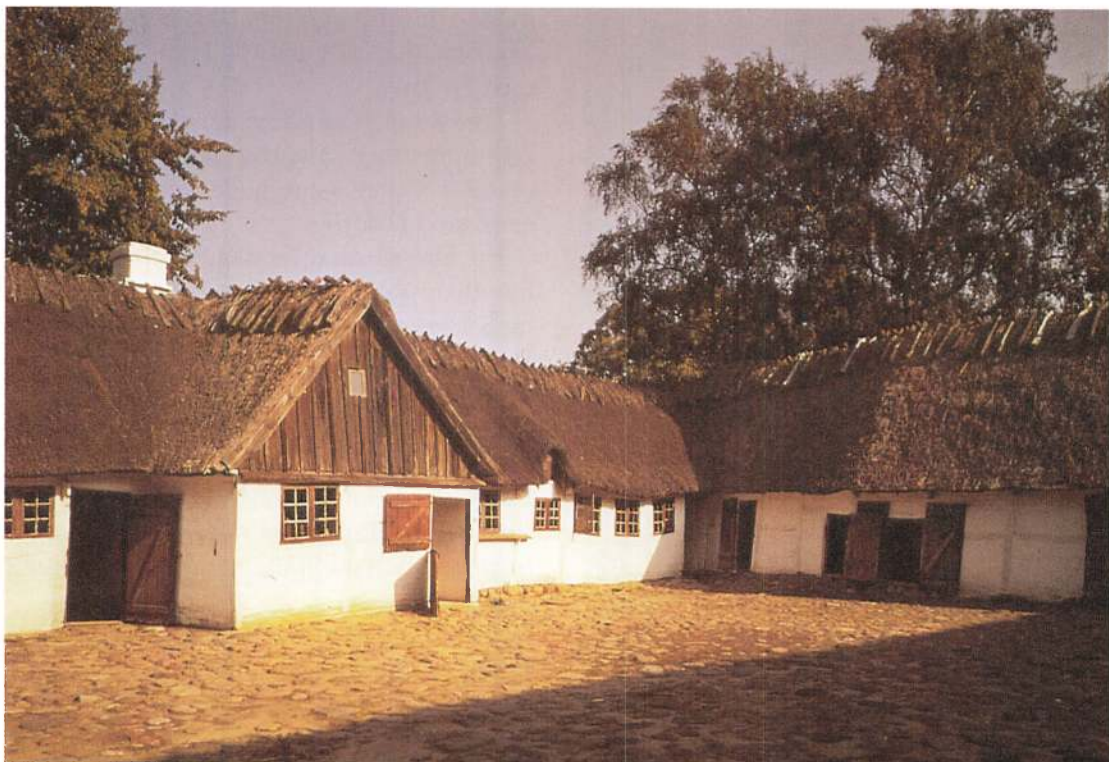
Pebringegården. Pebringegården fra Stevns er Frilandsmuseets imponerende eksempel på en sjællandsk 4-længet bondegård med overkalket bindingsværk. Karakteristisk for dette er bl.a., at stolperne står direkte på syldstenene uden brug af fodrem. Gården er genopført præcis i samme tilstand, som den fandtes før nedtagningen.
