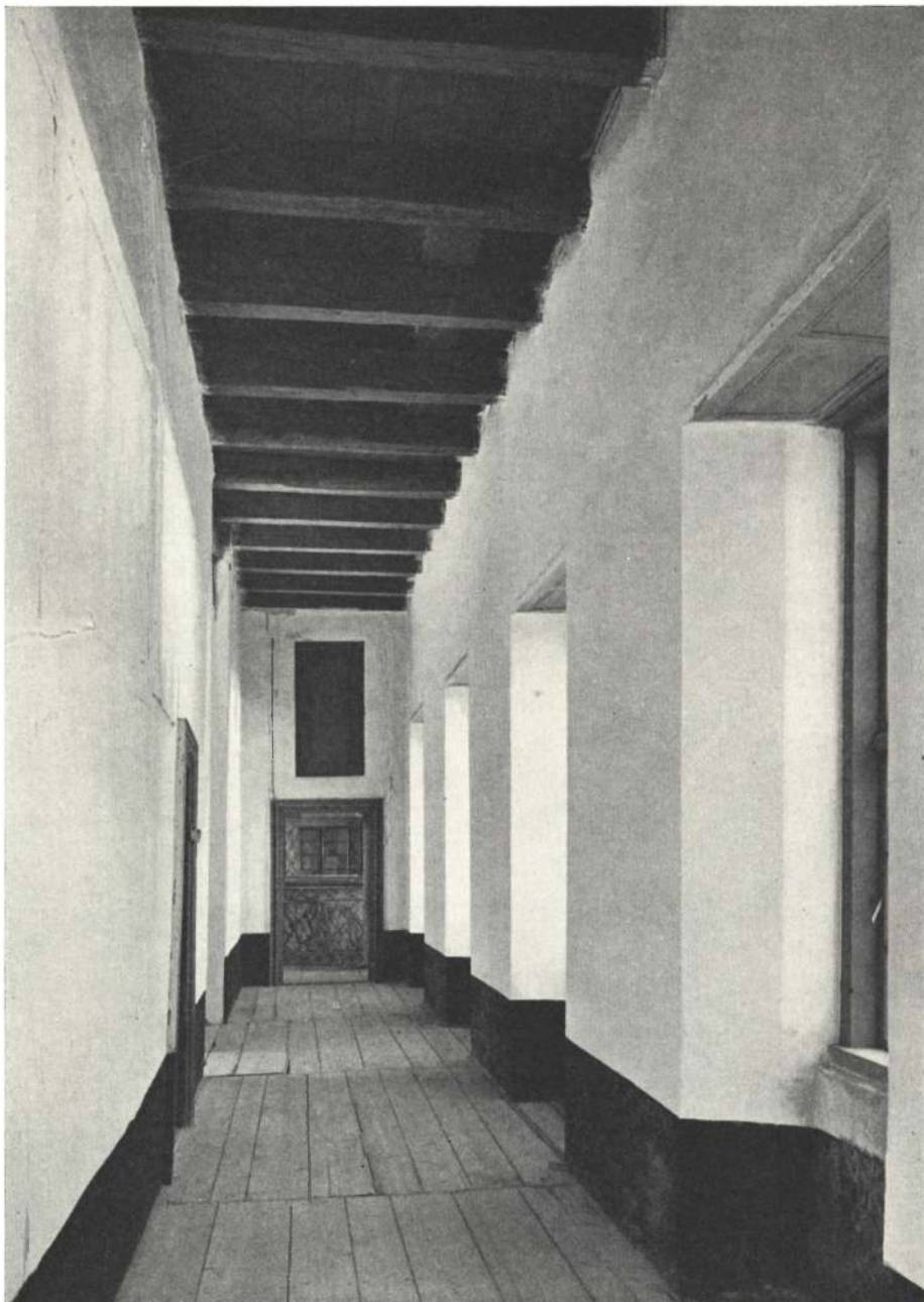
47. Gang i vestre sidefløjs øvre etage fra hovedbygningen til kirken.
