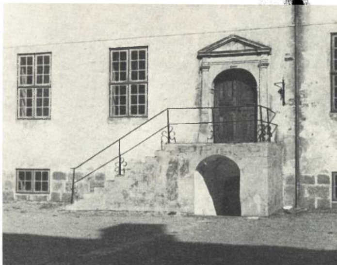
34. Østre sidefløjs portal.
