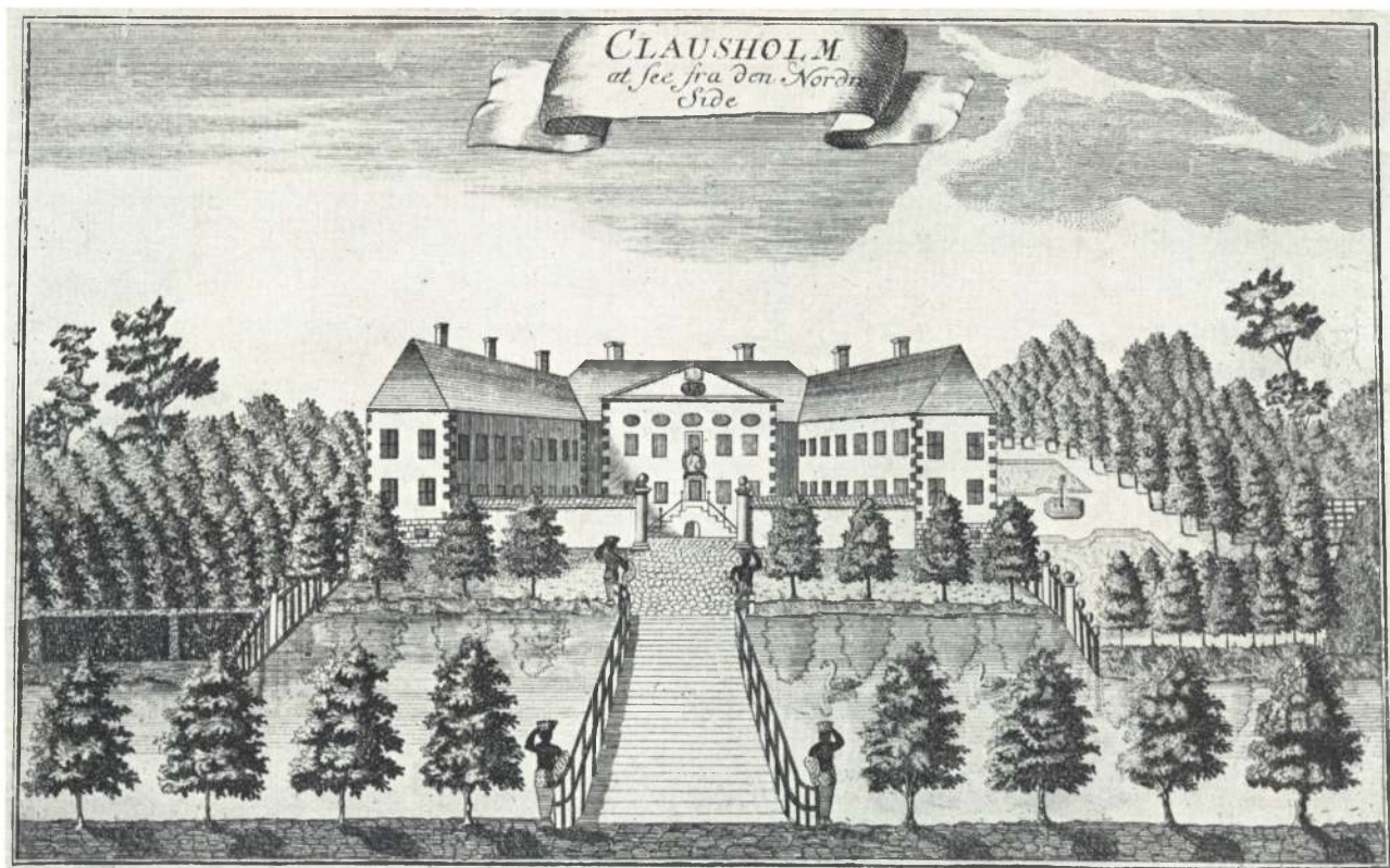
107. Clausholm med oprindelig spærremur og tosidet trappe, »hjørnekvadre» fra 1720'erne og bro med lygteholdere i »morians lignelse» fra 1735. Østfløjen (t. v.) er gengivet med et, vestfløjen med to fag vinduer for lidt. Sydfløjen mangler de vinduer, der har flankeret den brede midtrisalit. Stik i »Danske Atlas», 1787.
