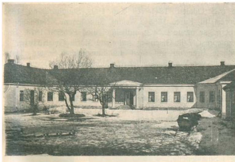
Facade og Interiør fra Gaardspladsen paa Skinnarbøl.
