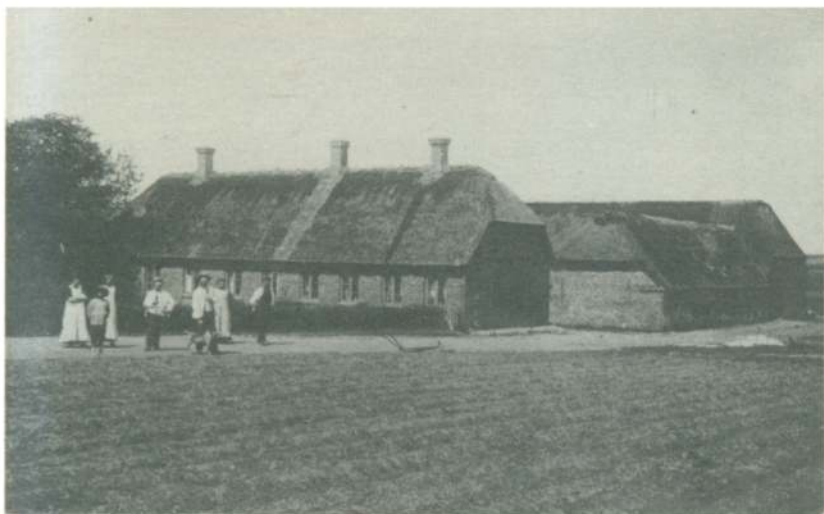
Chr. Thomsens ejendom Bækbo i Sdr. Lem, fotograferet ca 1910, hørte til de typiske lave firlængede vestjyske gårde, opført i mørkebrændte teglsten.
