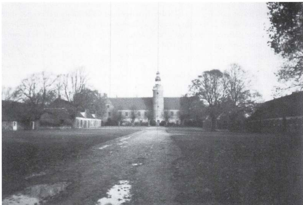
Et fotografi af hovedbygningen på Overgård, hvor Svenning Christensen i efteråret 1746 flygtede i strømpesokker hen over det høje tag. Han havde lagt en anden plan for sin fremtid end godsejer Arensdorf på Overgård.
