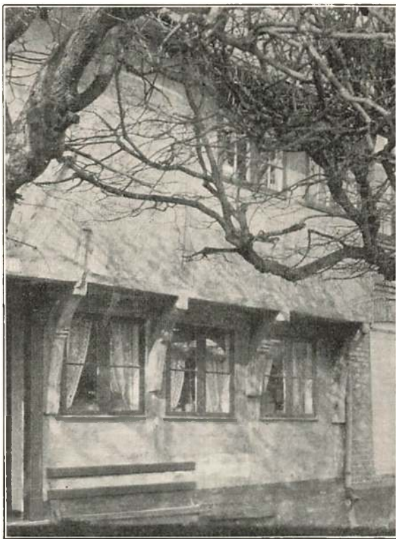
Afb. 21. Sengotisk Bindingsværkshus. Mk. de lange, krumme Knægte. c. 1530. Køge (nu flyttet). Fot.
