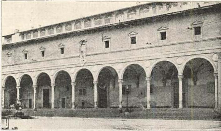
Afb. 33. Bygning i tidlig italiensk Renaissance. Hittébørnshospitalet i Florentz. 1419—45. (Jvf. Afb. 34).
