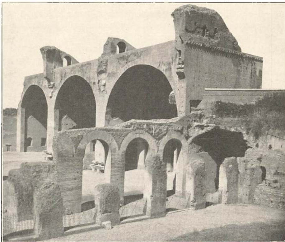
Afb. 4. Romersk treskibet, hvælvet Bygning fra Beg. af 4. Aarh. e. Chr. Gennem Forhallen ser man ind i det oprindelig krydshvælvede Midtskib, der aabner sig ind mod det tøndehvælvede nordre Sideskib. Maxentius Basilica i Rom. Fot.
