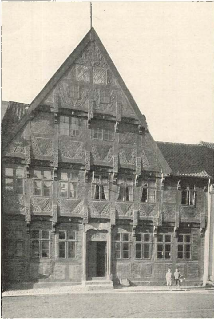
Afb. 45. Bindingsværks Patricierhus med knægtbygget Gavl mod Gaden og smal Sidefløj. Gotisk Renaissance. Dørens opr. Plads i yderste Fag til Højre. 1595. Hermann Reiminchs Gaard. Kolding. Fot.
