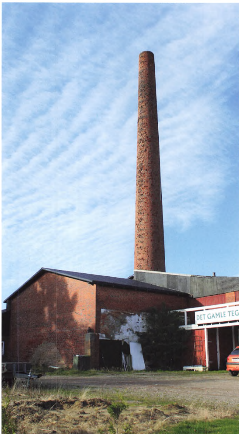
Helsingør Teglværk med sin markante skorsten, opført 1900.
