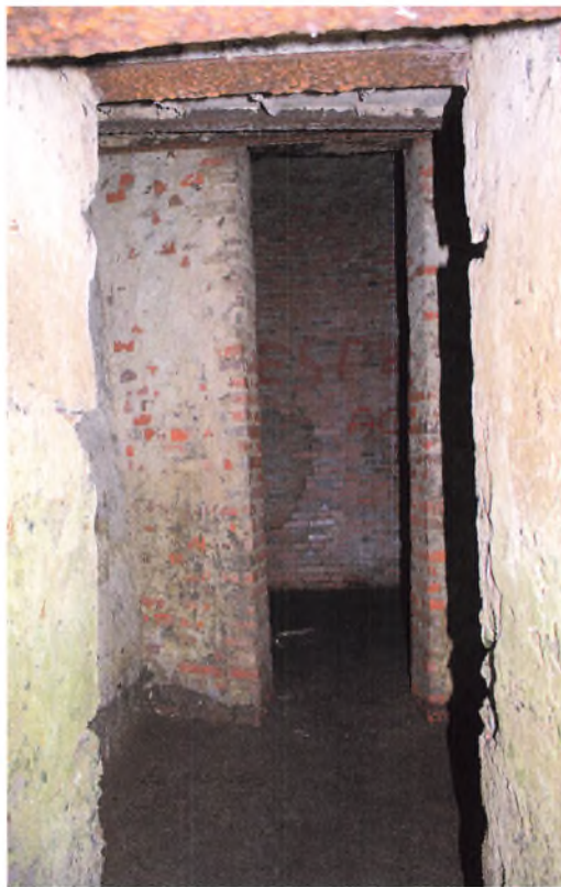
Til venstre: Forrummet og brønden set fra indgangen. På bagvæggen i brønden ses hullet ind til hulmuren samt noget af graffitien.
