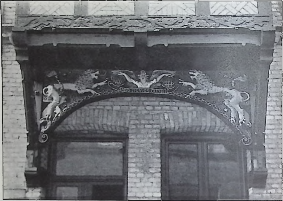
Hovedportal fra den tidligere, nu ombyggede, Apoteksgaard i Torvegade.
