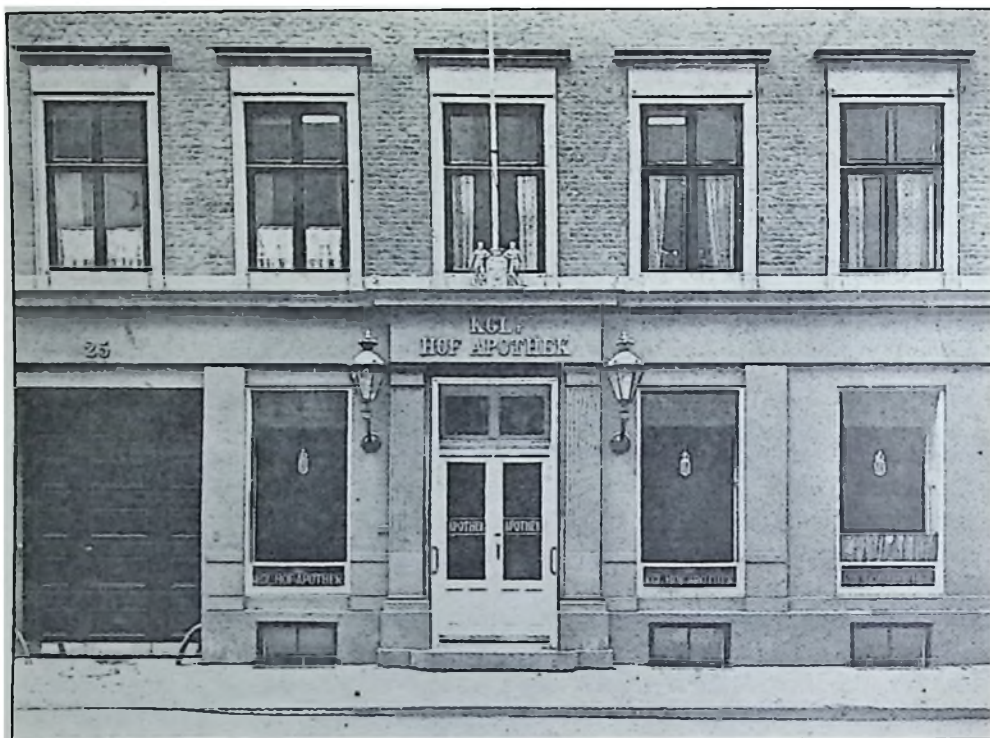
Det kgl. Hof-Apoteks Facade efter Ombygningen i 1915 (St Kongensgade 25).
