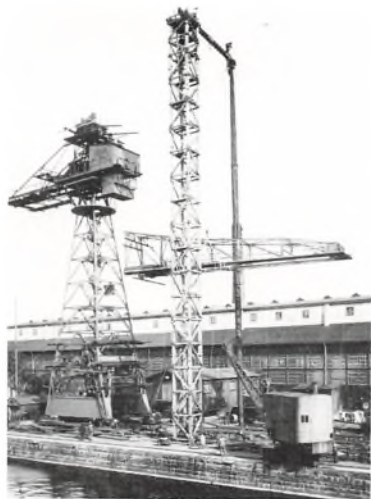
En ny kran monteres ved dok II i 1931. I baggrunden skibsbygningshallen.
