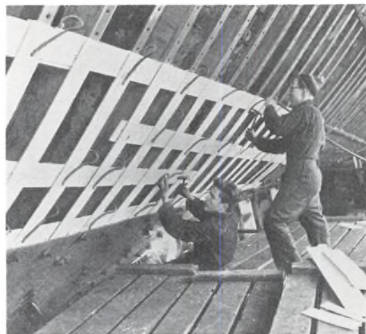
Undertiden laves skabelonerne til klædningspladerne direkte efter skibets spanter, som her på nybygning nr. 327 (M/F Halsskov).
