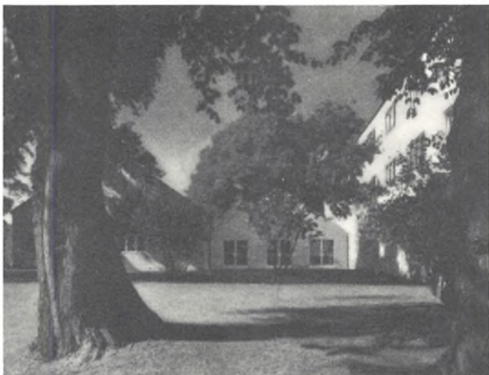
Danmarks Journalisthøjskole i Vennelystparken, opført 1956–57, arkitekt: C. F. Møller. Skolen begyndte i 1946 som »Journalistkursus ved Aarhus Universitet«, blev i 1958 udvidet med et særligt »Nordisk Journalistkursus« og endelig i 1962 omdannet til en journalisthøjskole.
