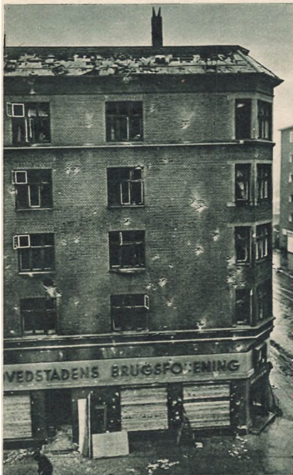
Bygning i Njalsgade i København efter Bombenedkastningen den 27. Januar 1943. Læg Mærke til, hvor Facaden er gennemhullet som en Si af talrige Sprængstykker efter den 225 kg Bombe, der eksploderede midt i Gaden
