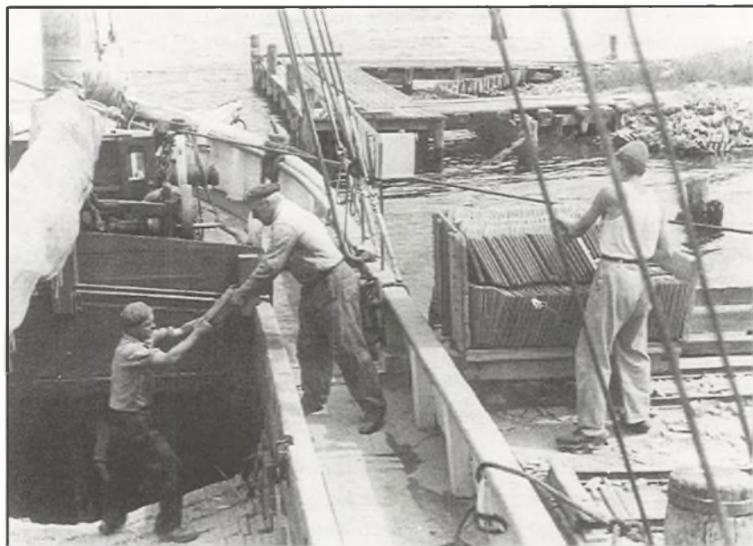
Lastning af skonnert med tagsten og mursten. Skibsdrengen står i lastrummet og tager i mod stenene – fire »i et kast« – og stuver dem med halm imellem. Teglværket Grønland, Egersund, ca. 1950. (Museet på Sønderborg Slot).
