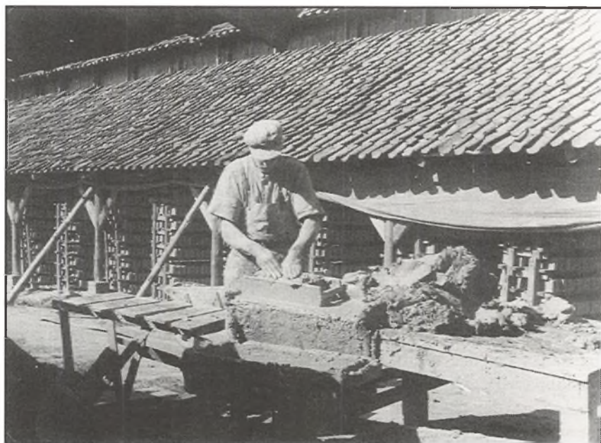
Håndstrygning af mursten. Strygeren flytter ca. 10 tons ler to gange i løbet af arbejdsdagen og laver ca. 4.000 mursten. Teglværket Grønland, Egersund, ca. 1950. (Museet på Sønderborg Slot).
