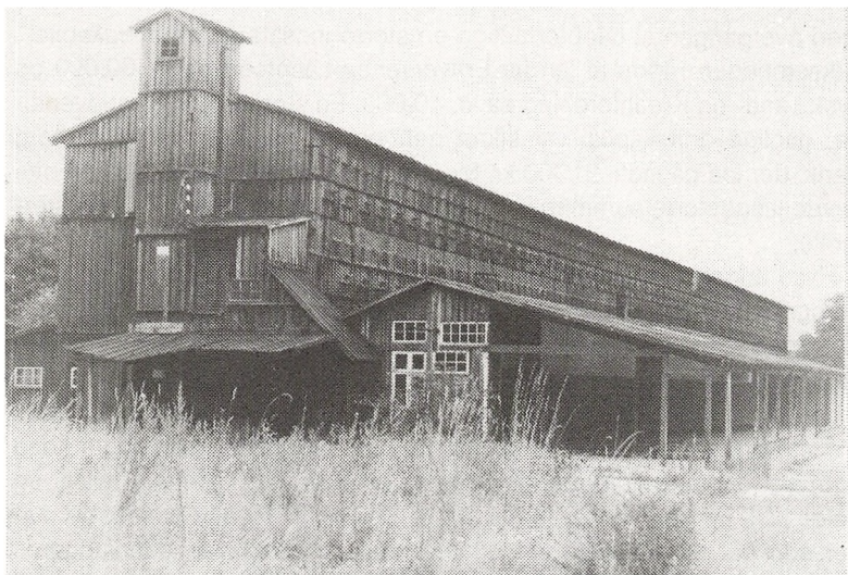
Fig. 3. Den dominerende produktionsbygning på Klostermølle er tørreladen af træ, der er i 3 etager og måler 90 m i længden.
