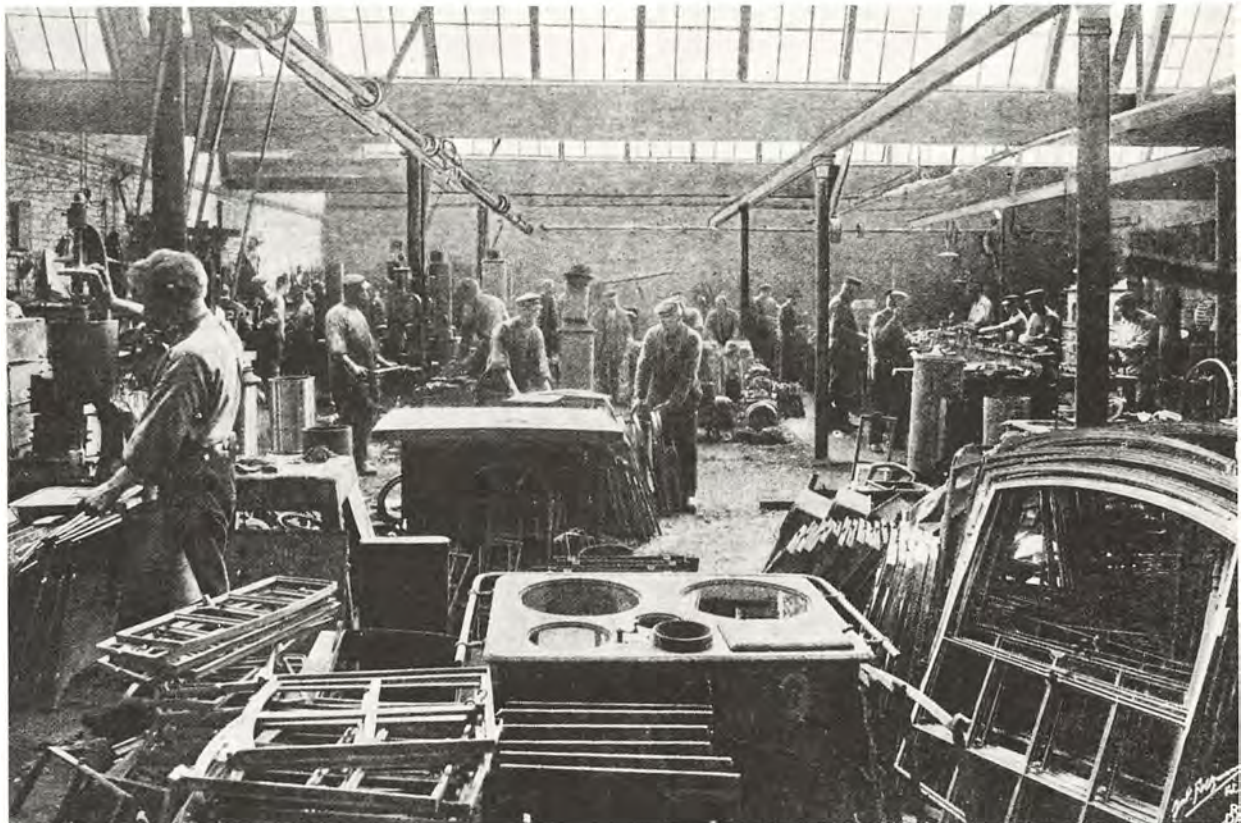
Figur 3: Håndværksmæssige færdigheder var længe en væsentlig forudsætning for produktionen på de „gamle“ jernstøberier. Fotografierne, der er taget senest 1904, viser en afdeling af støberiet og beslagværkstedet for kakkelovne, komfurer og bygningsstøbegods på H. Rasmussen & Co.'s Jernstøberi. (Kilde: De danske Byerhverv, Øerne, 1904, side 30 f.).
