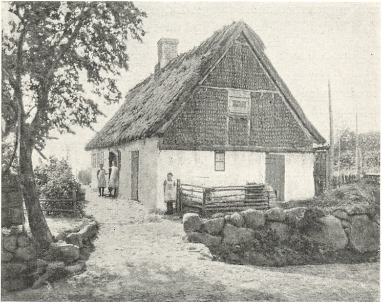
Dukket Gavl paa et Hus i Estrup. Allindemagle Sogn i Sorø Amt. (Forf. fot.)
