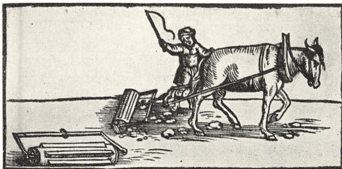
Lægte- eller Stangtromle fra 16. Aarh. Efter Adam Lonicer.
