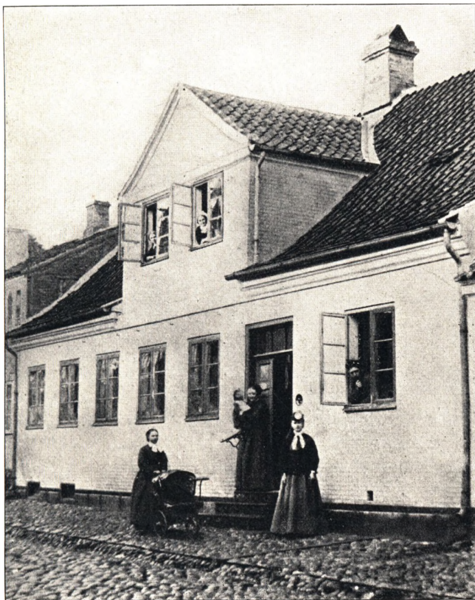
Huset i St. Annagade.
