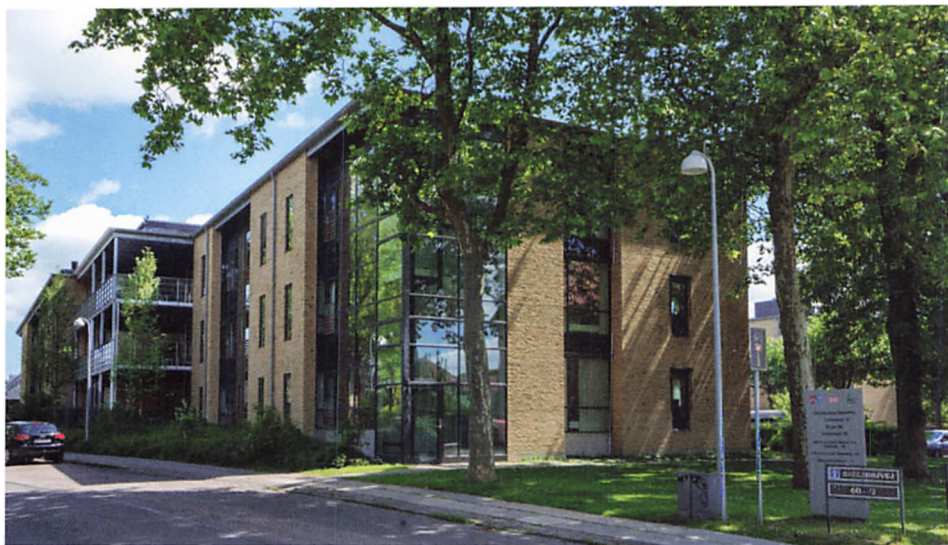
„Bauehøj“ som det ser ud efter renoveringen.
