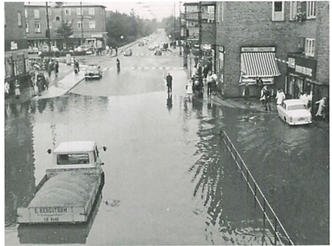
Viadukten, der fører Frederiksdalsvej under jernbanen, står under vand. Tv Schous Sæbehus lukkede i 1974. Th. Bager og Konditori. 1972. B6623.
