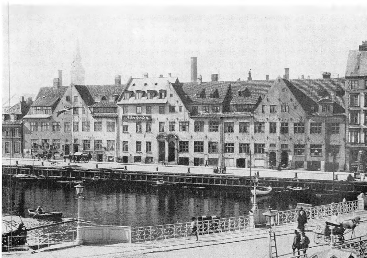
„De seks Søstre“ eller „Nybørs“, opført som Købmandshuse af Rentemester Henrik Müller o. 1650. De blev nedrevet 1900 for at give Plads for Privatbankens nye Bygning.
