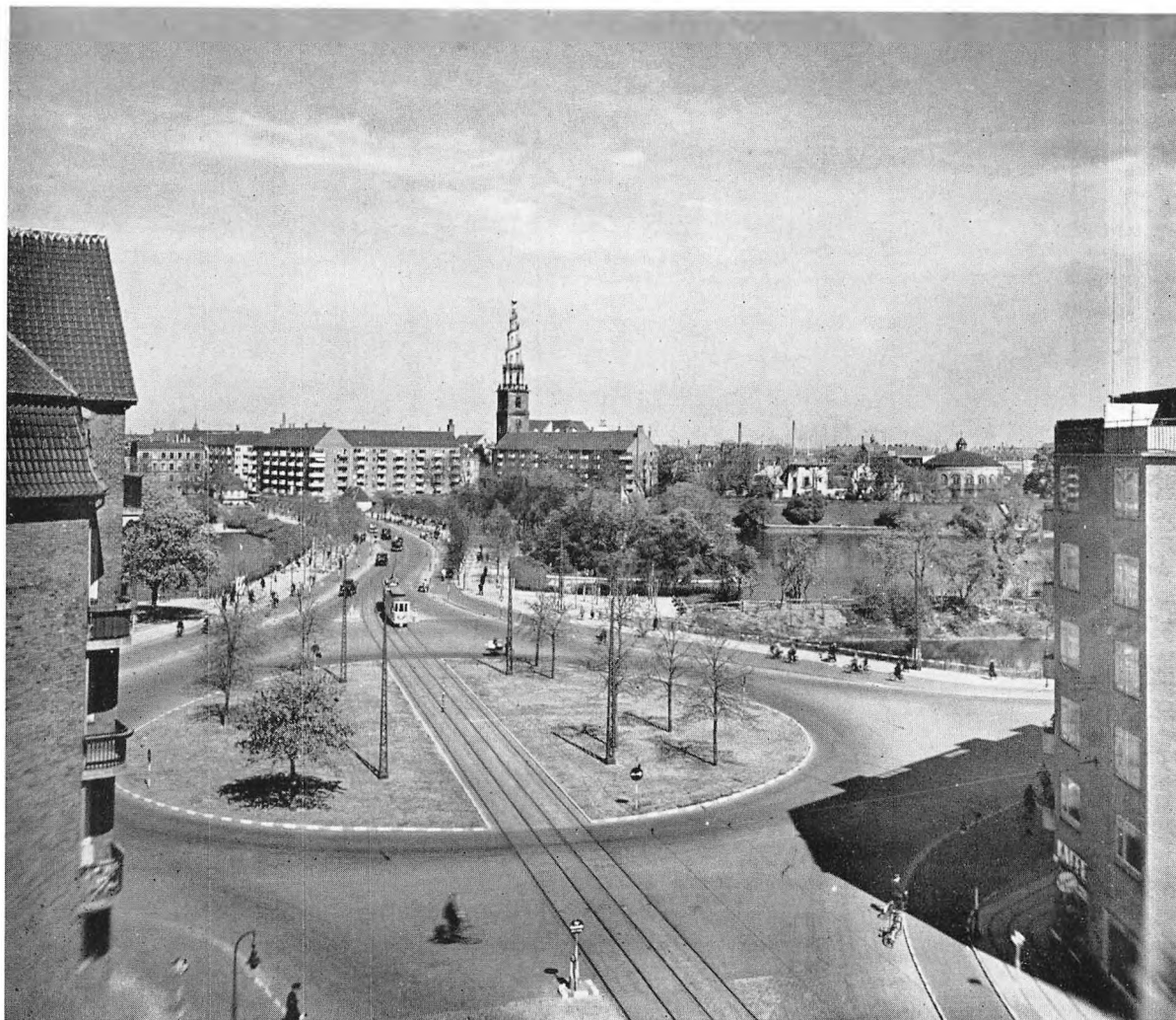
Rundkørsel paa Amagerbrogade.
