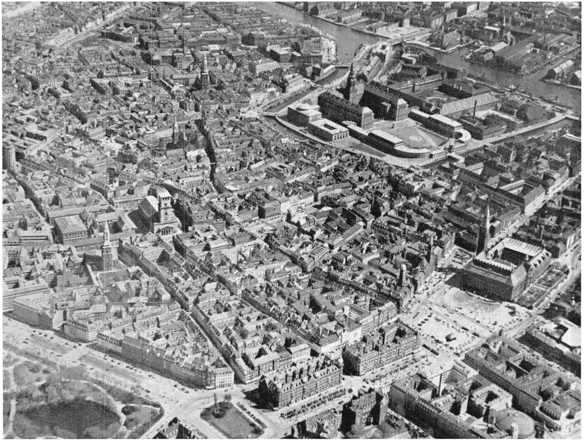
Luftfotoграфи over den gamle By fra Jarmers Plads mod Christiansborg. I Forgrunden ses Nørre- og Vestre Boulevard paa det gamle Voldterræn. Helt i Forgrunden ses Resterne af Jarmers Taarn, der fra gammel Tid markerer Knækket i Voldsystemet. I Forgrunden t. v. de i Ørstedsparken bevarede Rester af Voldterrænet.
