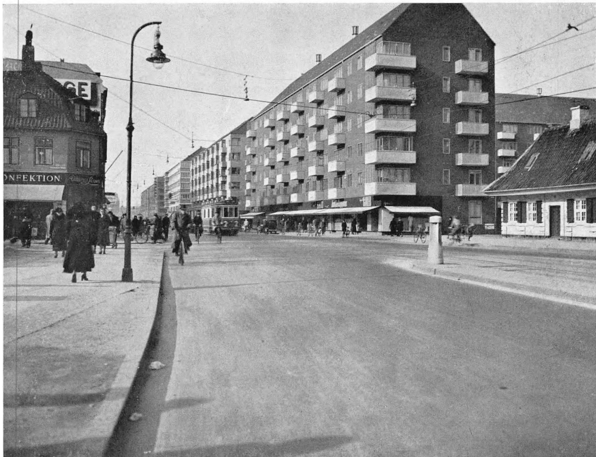
Amagerbrogades Overførsel over Voldgraven.
