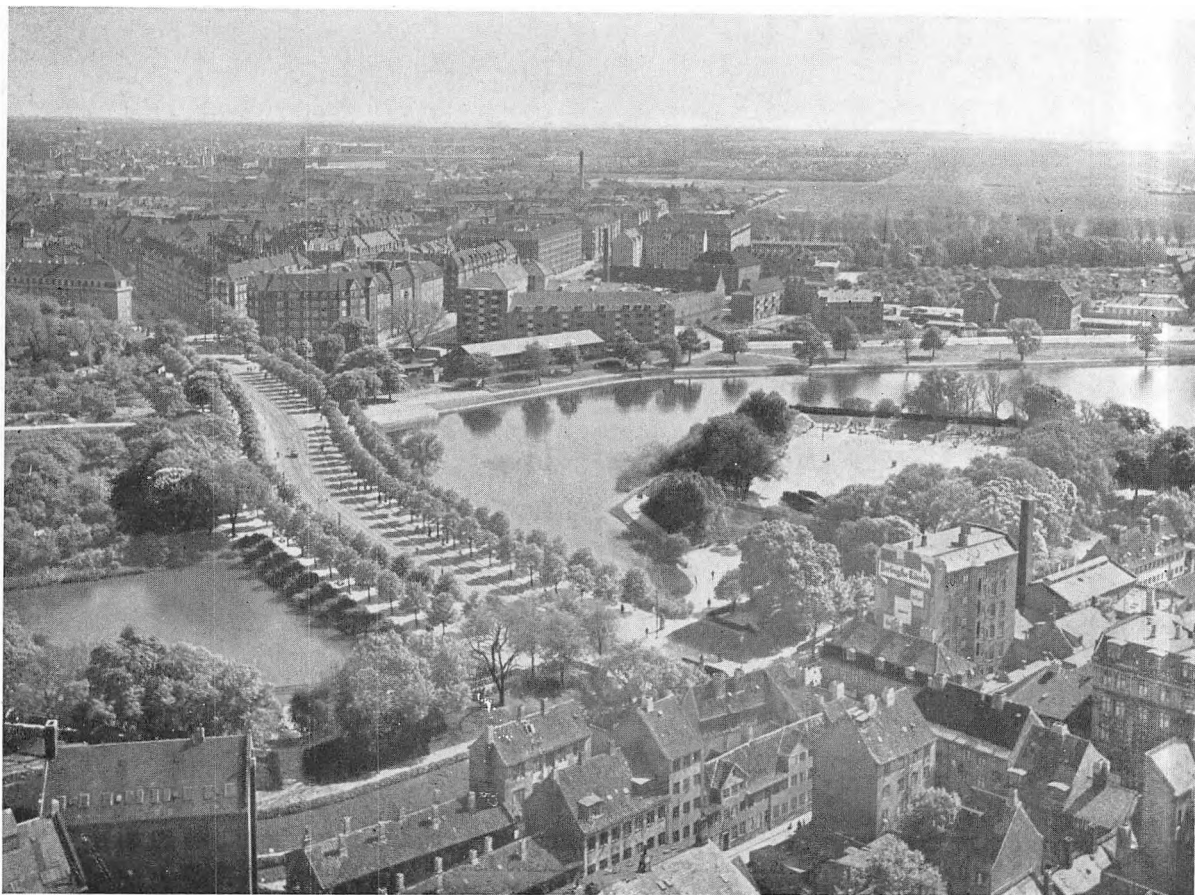
Amagerbrogades Overførsel over Voldgraven, set fra Luften.
