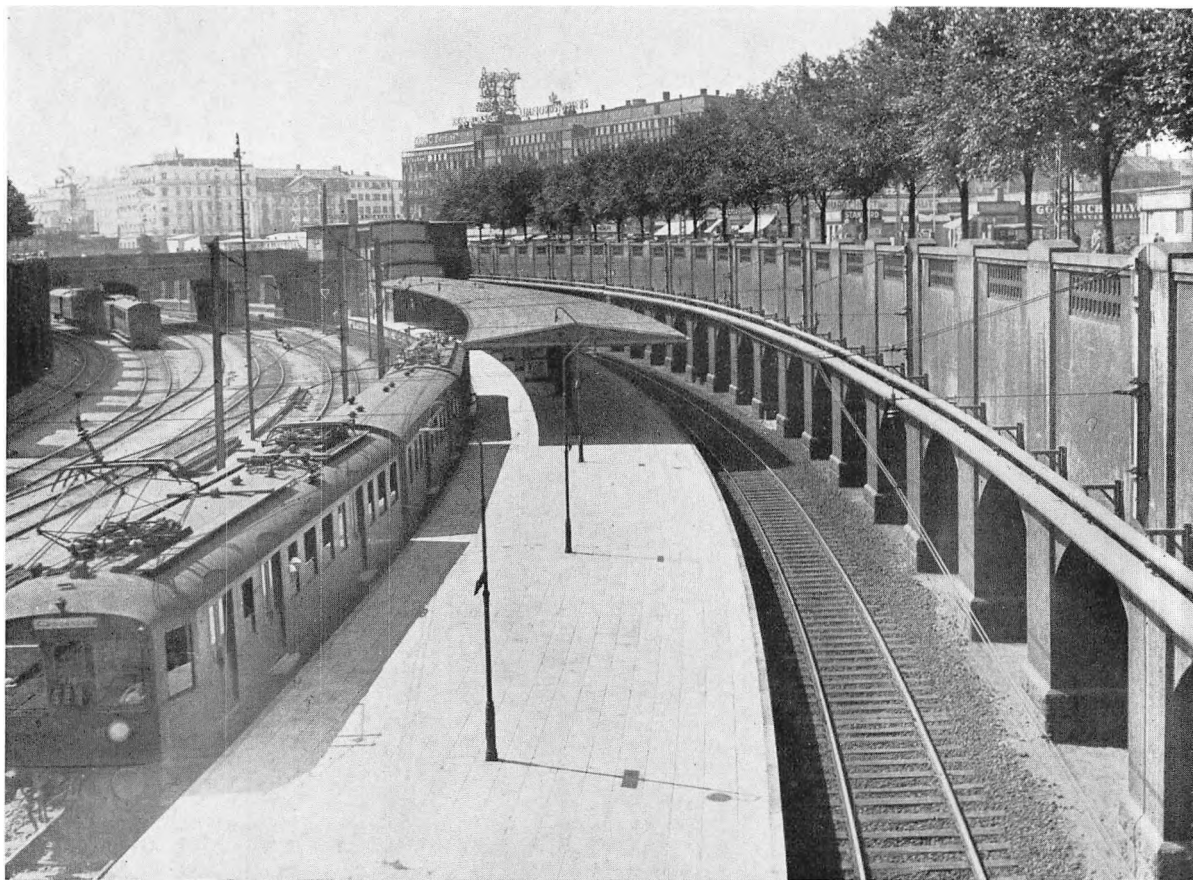
Vesterport, forsænket S-Banestation paa Boulevardbanen, her i aaben Grav; fra Jarmers Gade til Østerport Station er Banen overdækket.
