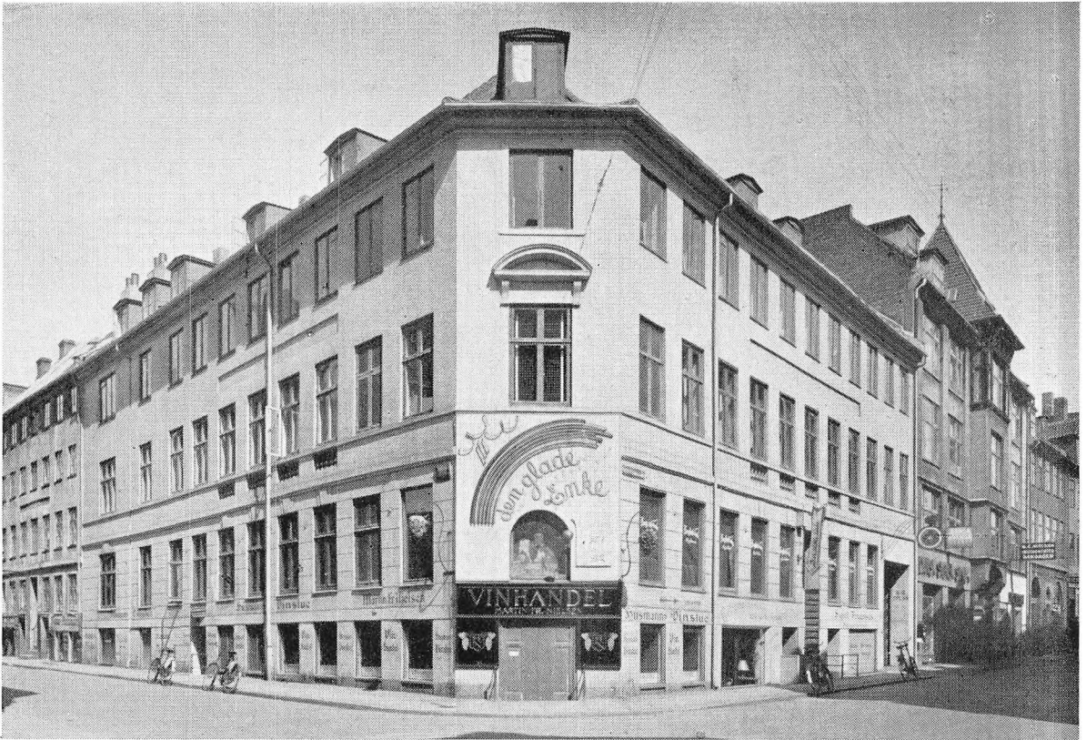
Branden 1795 gav Anledning til det første af Magistraten udstedte Byggeregulativ. Der kræves bl. a. heri, at Hjørnerne paa nye Huse „brækkes paa 5 Alens Bredde, til et Fag Vindue med Piller“. Ejendommen Vestergade 12 er opført 1796.
