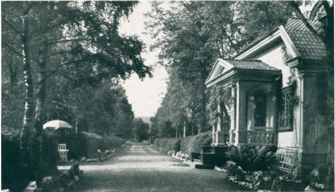
«Verksgaten» — den gamle Trondhjemsvei.
