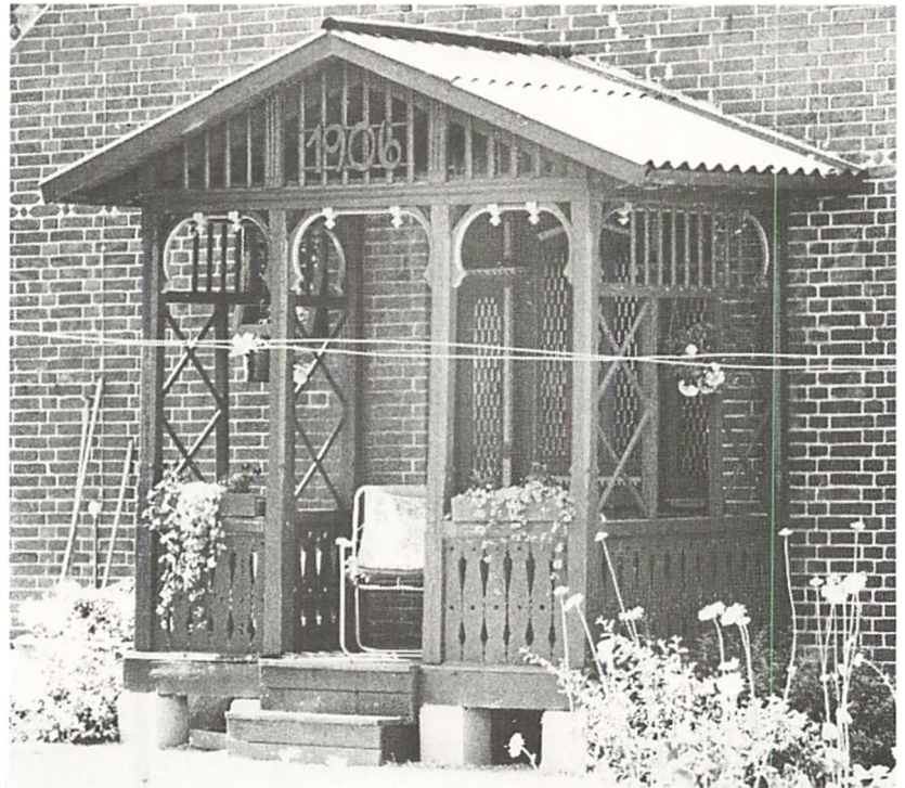
Fig. 1. Veranda ved hus i Kjellerup, Viborg amt.
