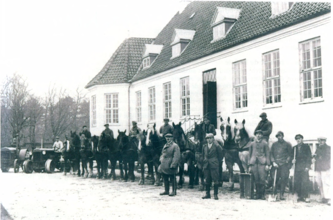
Klintsøgårds hovedbygning fra 1912. Efter gården var udstykket var der i hovedbygningen først råkostkuranstalt, så rekonvalescenthjem og nu idrætshøjskole.
