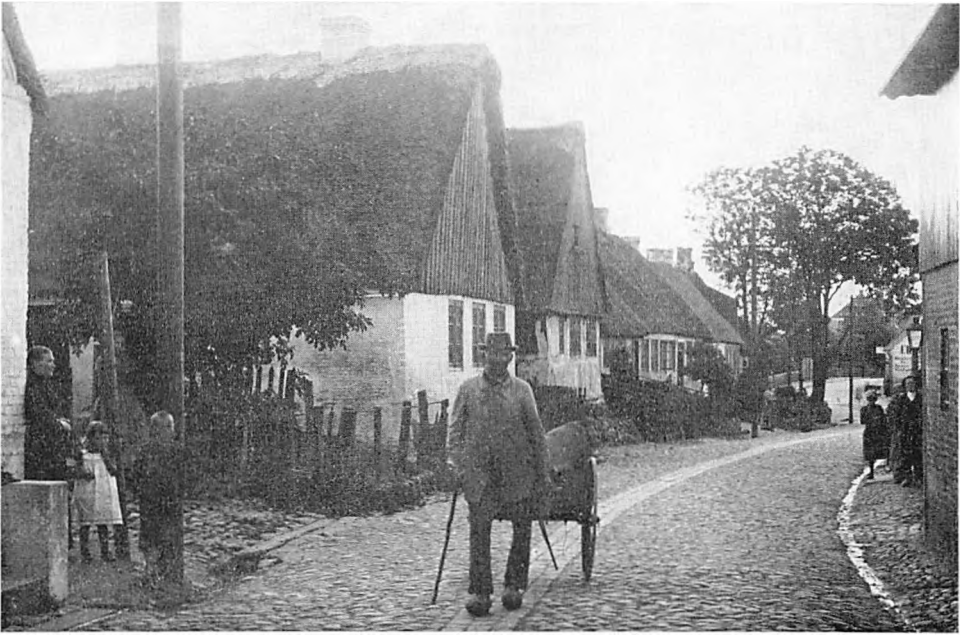
Så hyggeligt var der i Bøndergårdene. Bemærk rendestenen i højre side af billedet.
