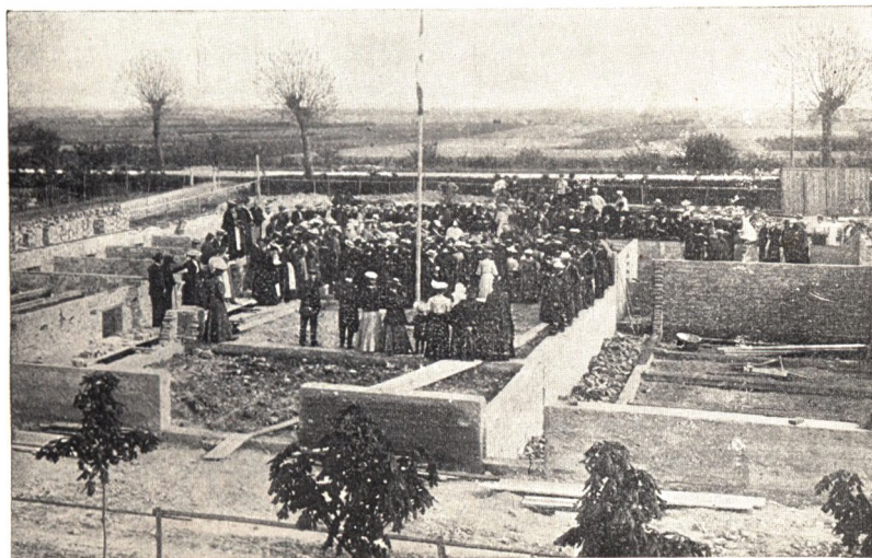
GRUNDSTENEN TIL KÆREHAVE HUSMANDS- OG HUSMODERSKOLE NEDLEGGES
