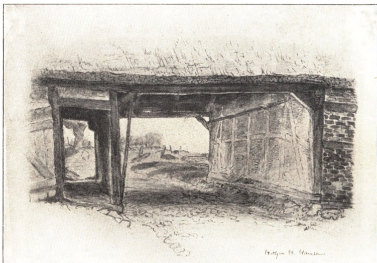
Indkørselen fra Vejen ind i den tæt sammenbyggede Gård. Efter Akvarel af Holger Hansen.
