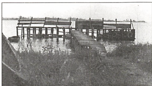
Lodsbroen ved Grønsund, bygget 1912
