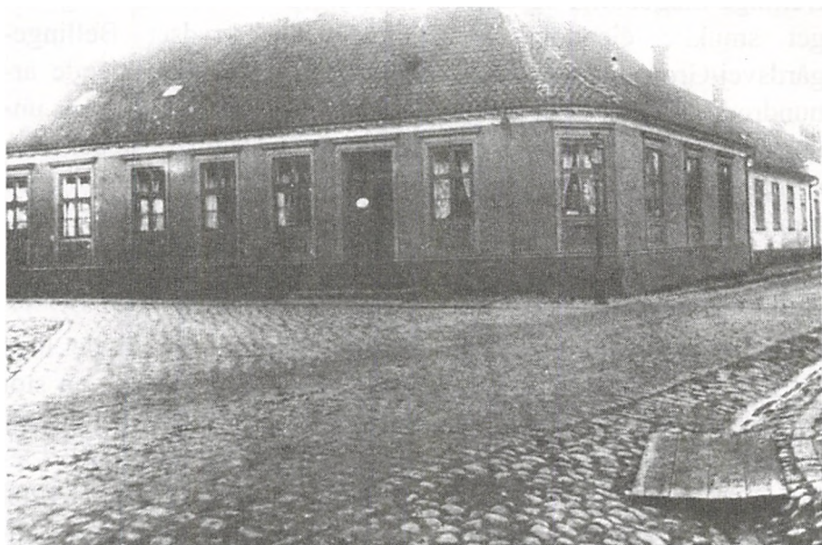
Lægeboligen på Klokkerplads i Stubbekøbing ca. 1900
