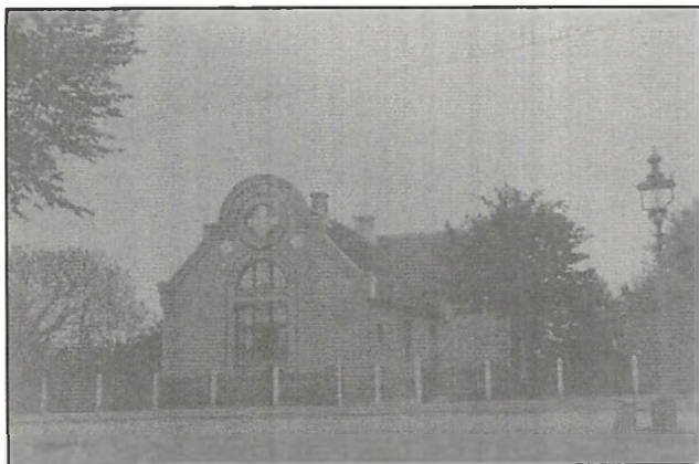
Afholdslogen opført 1862 som sygehus af arkitekt Tvede.
