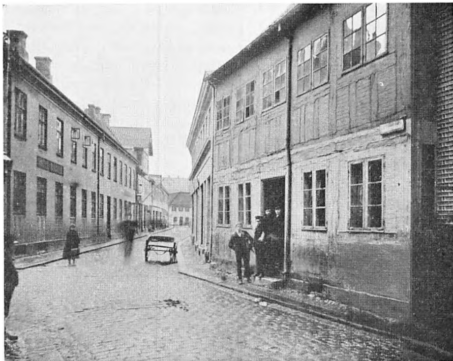
Guldsmedgade i 1890'erne før gaden blev brudt igennem Klostergade frem til Norreallé. Familien Lange boede i huset i Klostergade, der ses i billedets baggrund.
