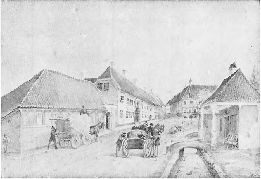
Ved Studsgades port.
