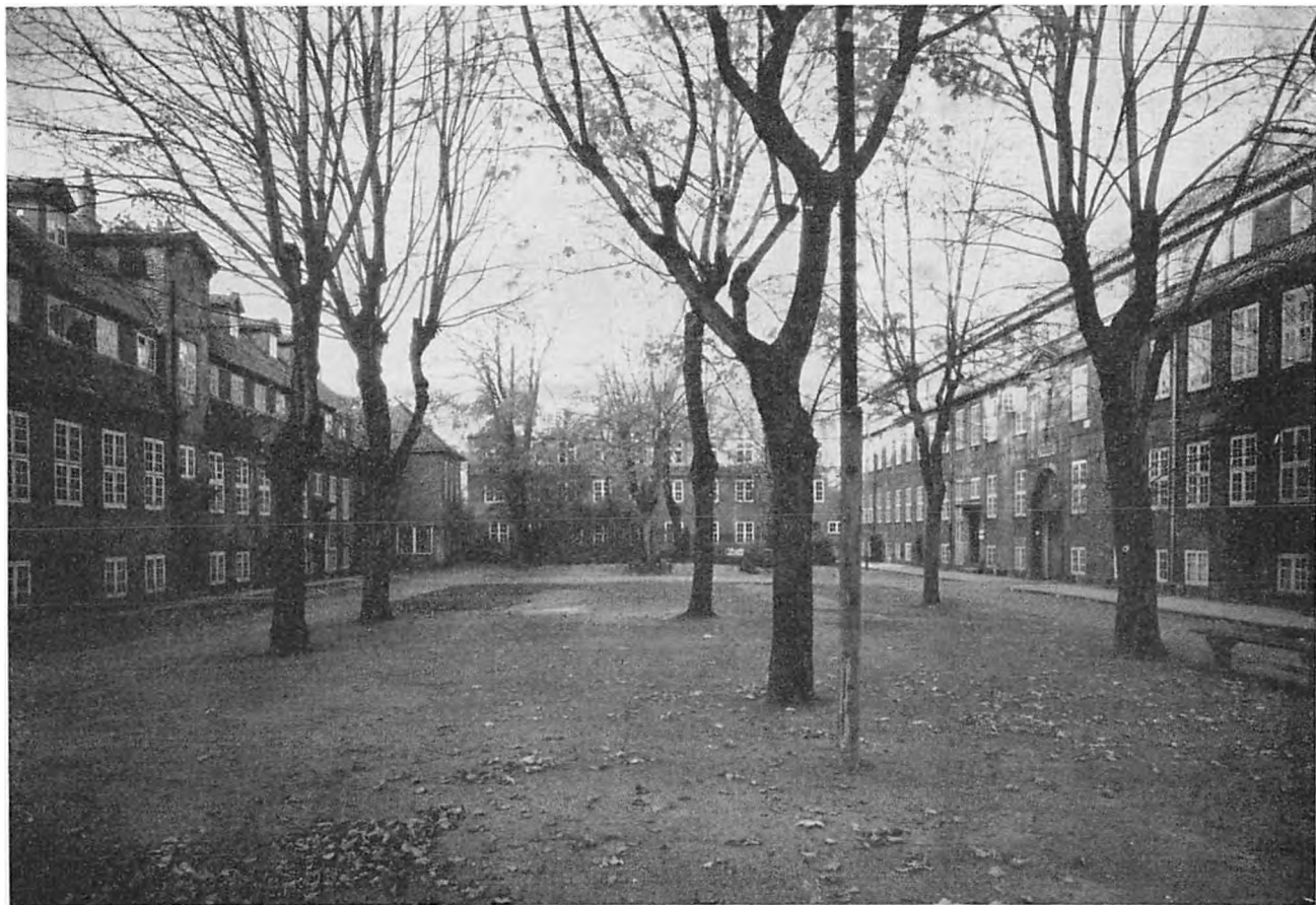
Fig. 19. Guldhuset's gård. Fra venstre: Kirurgbygning, officerslazaret, tværbygning og hovedbygning (1776).
