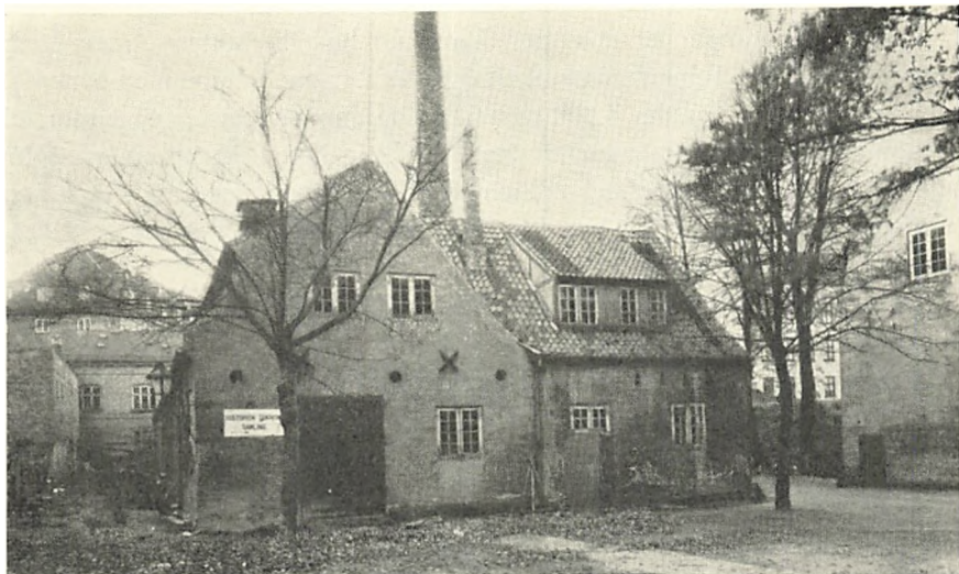
Fig. 21. Fruentimmerlazaret og vaskeribygning umiddelbart før nedbrydning.
