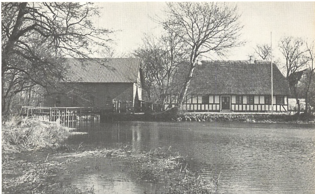
Fulden Mølle. bygningen til venstre. Mange turbinemøller er gamle, ombyggede vandhjulsmøller, men Fulden Mølle er født med turbine. Bygget af Frichs i Århus.
