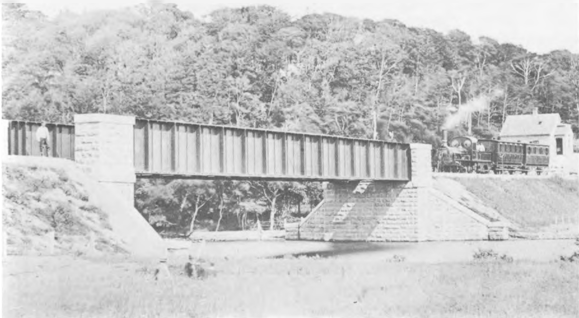
Jernhanebroen over Remstrup å - 1871 («Danmarks Damp Lokomotiver» v/ William Bay)
