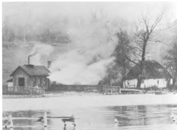
Statsbanernes pumpestation ved siden af »Slukefter«
