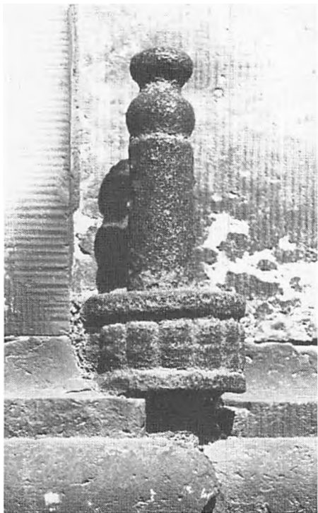
I pavillonernes sidemure ses endnu de svære hængselsstabler, som bar den tunge gitterport for 250 år siden. Foto forf.
