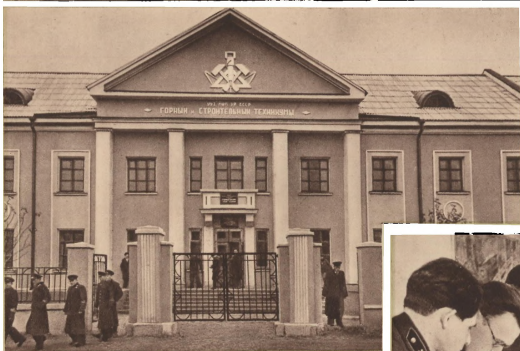
Bild oben – das Gebäude des Montanbautechni- kums in Stalinogorsk. Hier wird technisches Perso- nal für das Moskauer Kohlenbecken ausgebildet.
