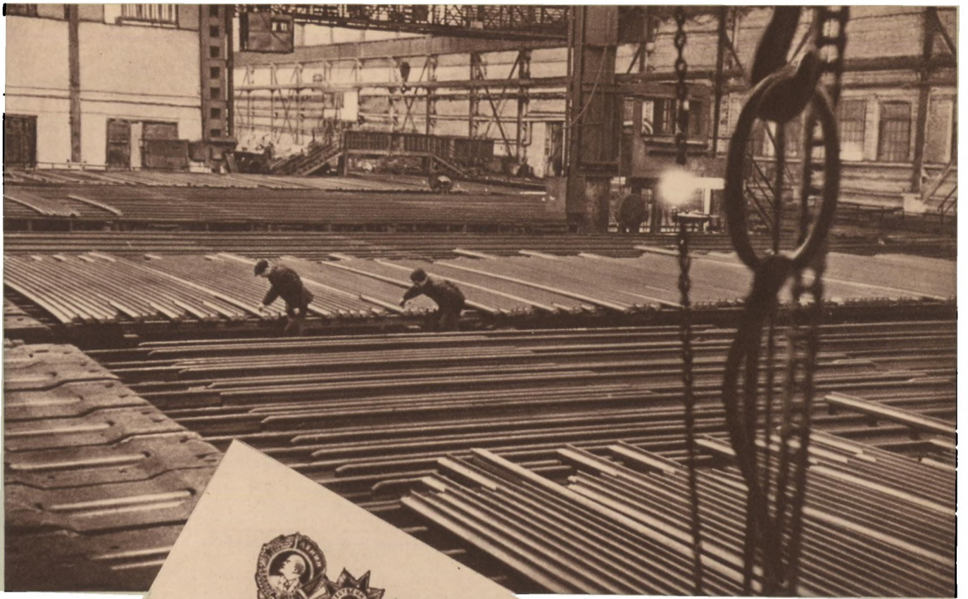
Ein bedeutender Teil dieser Schienen und Balken ist aus Stahl gewalzt, der von Alexander Schaschkow über das Produktionsprogramm hinaus gewonnen wurde.
