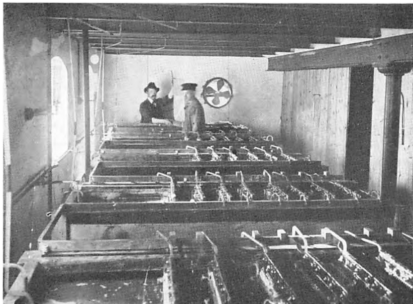
Elektrolysekar med elektroder. Svendsen i baggrunden med et katodenet, 1903.
