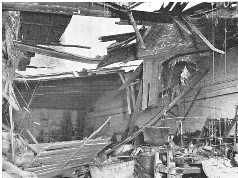
Skorstenen har knust fabrikstaget, 1934.
