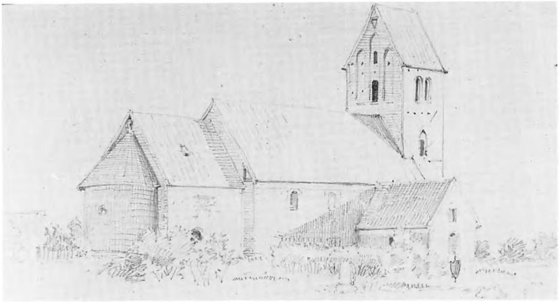
Fig. 34. Kirken set fra nordøst sommeren 1890, året før den gennemgribende restaurering. Blyantsskitse af kgl. bygningsinspektør J. Vilh. Petersen. Privateje. — Die Kirche im Sommer 1890, im Jahr vor der durchgreifenden Restauration, von Nordosten gesehen. Bleistiftskizze.
