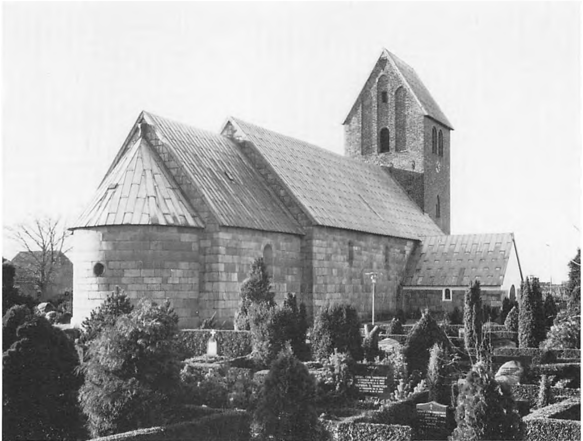
Fig. 2. Kirken set fra nordøst. NE fot. 1979. — Die Kirche von Nordosten gesehen.
